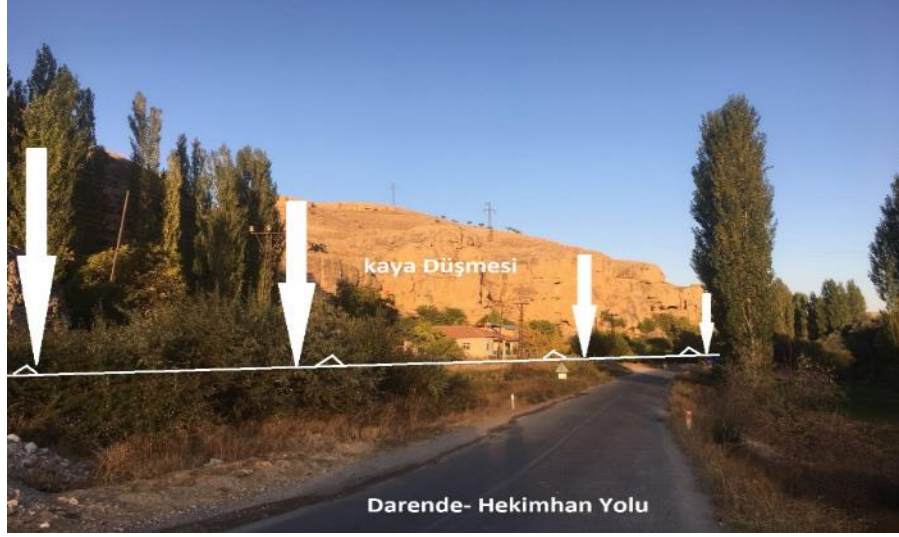
Fotoğraf 5: Kaya düşmesinden dolayı Ayvalı'dan geçen Darende- Hekimhan karayolu büyük risk altındadır. Ayrıca bu kaya düşmesi konutlarda ve zirai sahalarda ciddi tahribatlara yol açmıştır.
