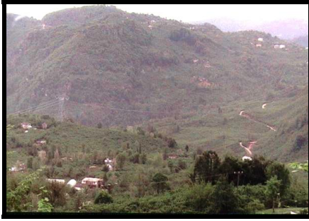
Foto 5: Ahırlı köyü genel görünümü
