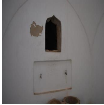
Fotoğraf 11: Sıcaklık, lüleler ve su deposu kontrol penceresi
