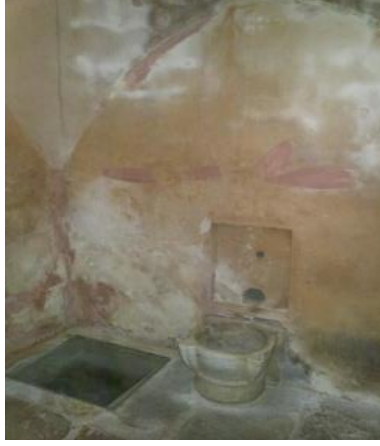
Fotoğraf 4: Sıcaklık, kurna ve lüleler
