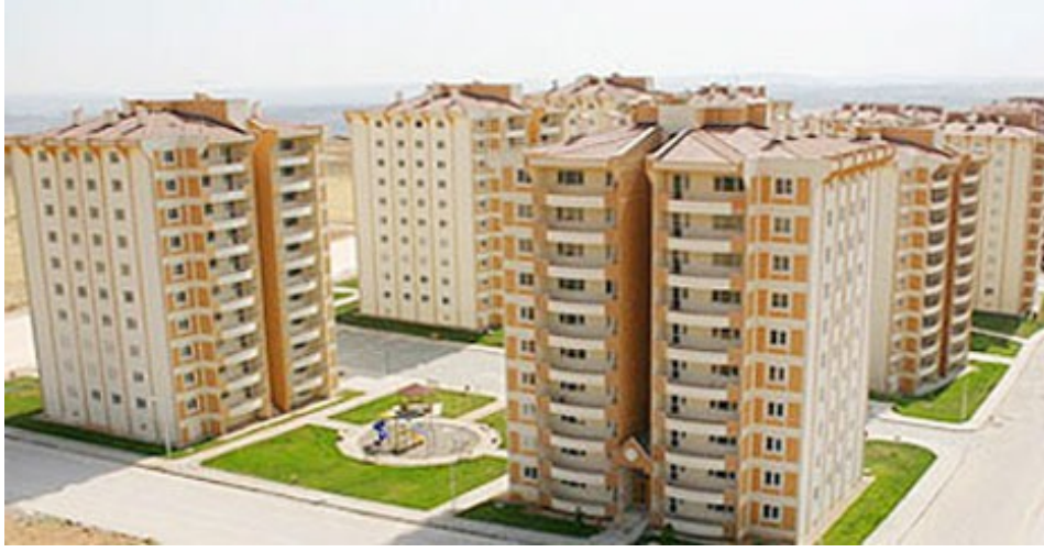
Foto 5. Kentsel Dönüşüm Planlarının Yapılmasından Sonra Ön Görülen Alanlardan Bir Görünüm
