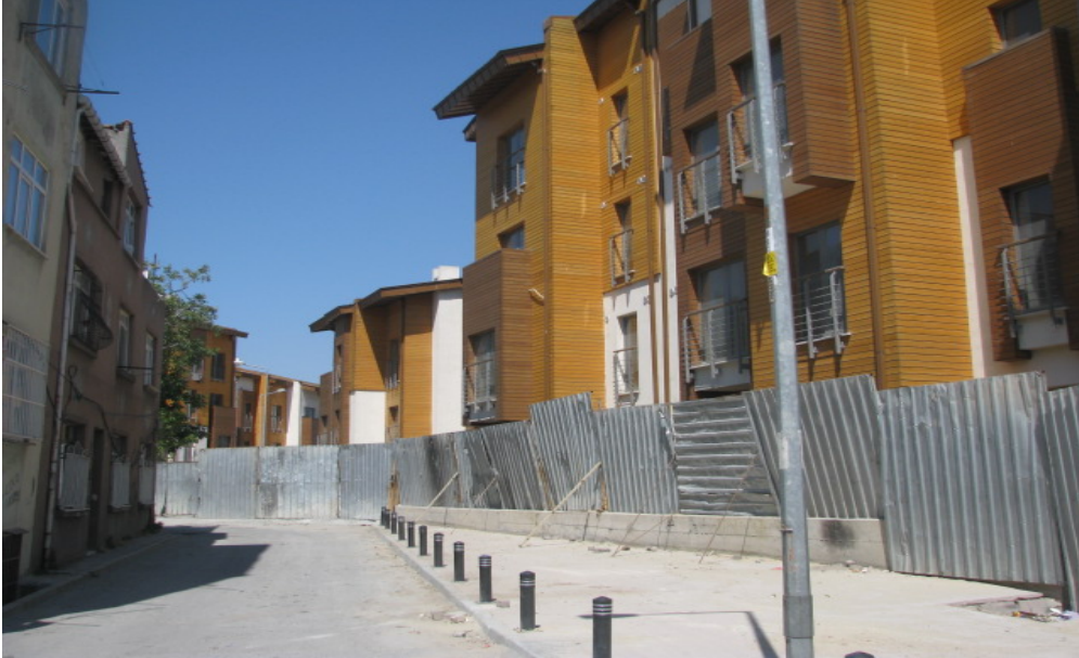
Foto 2: İstanbul’da Sulukule’de (Fatih) Kentsel Dönüşüm Yapılan Konutlardan Bir Görünüm
