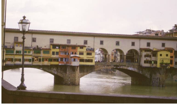
Foto 12: Floransa'daki Ponte Vecchio Köprüsü'nün 2001'deki Genel Görünüşü.
