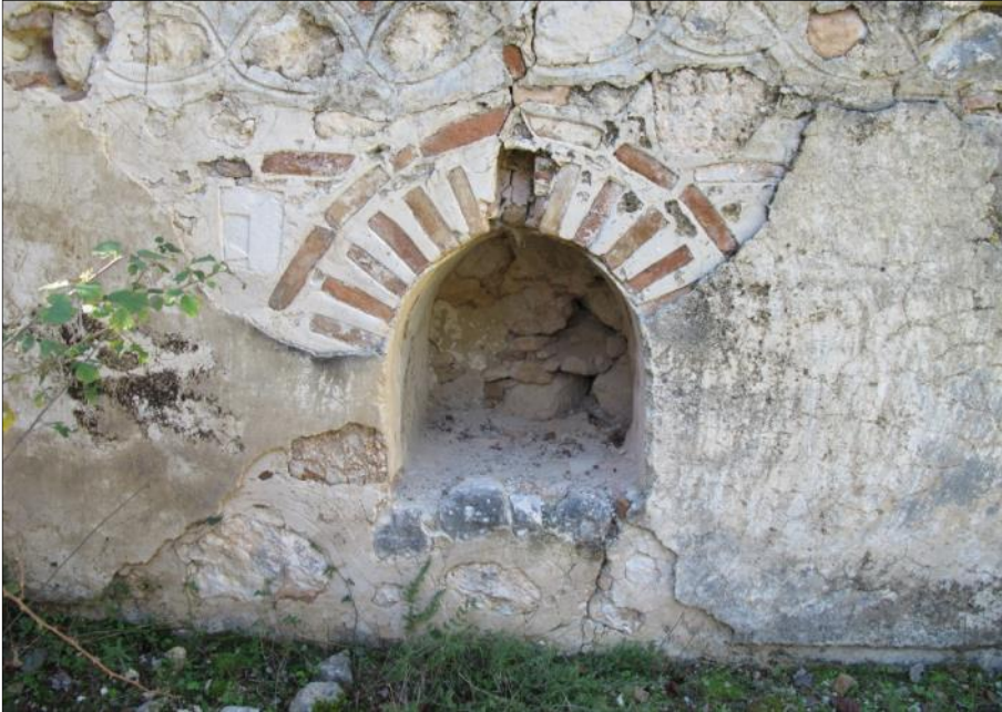
Resim 6. Mescidin İç Duvarından Kemerli Niş Detayı.
