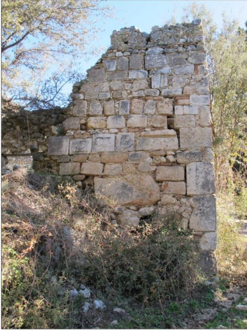
Resim 7. Mescidin Batı Duvarı Dıştan Görünümü.
