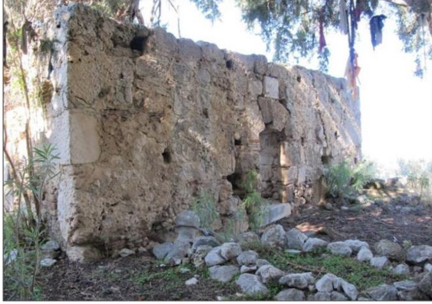
Resim 8. Türbe'nin Doğu Giriş Cephesi.
