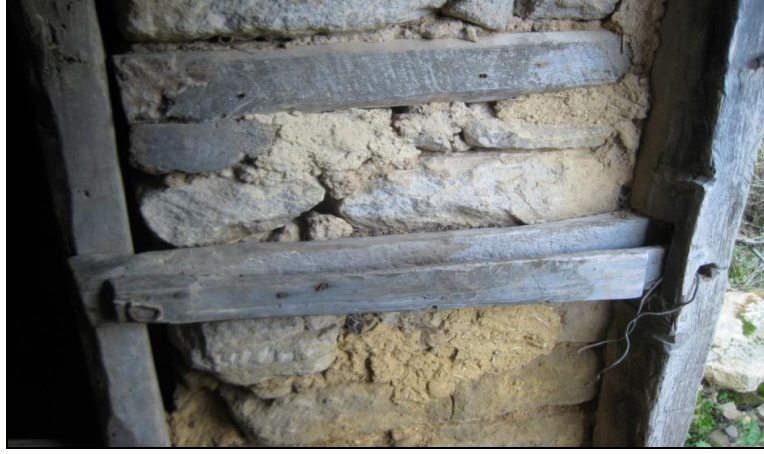
Foto 8: Geleneksel Kilit Sistemi, Ev-1 Zemin Kat Kapı Kasası (Fotoęraf: K. R. KAVAS)
