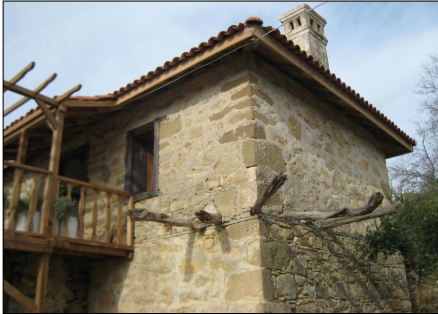
Foto 2: Ahşap kirişlerin döşeme seviyelerinden güney ve doğu cephelerde dışarı doğru yaptığı çıkımlar (Ev-2) (Fotoğraf: K. R. KAVAS)
