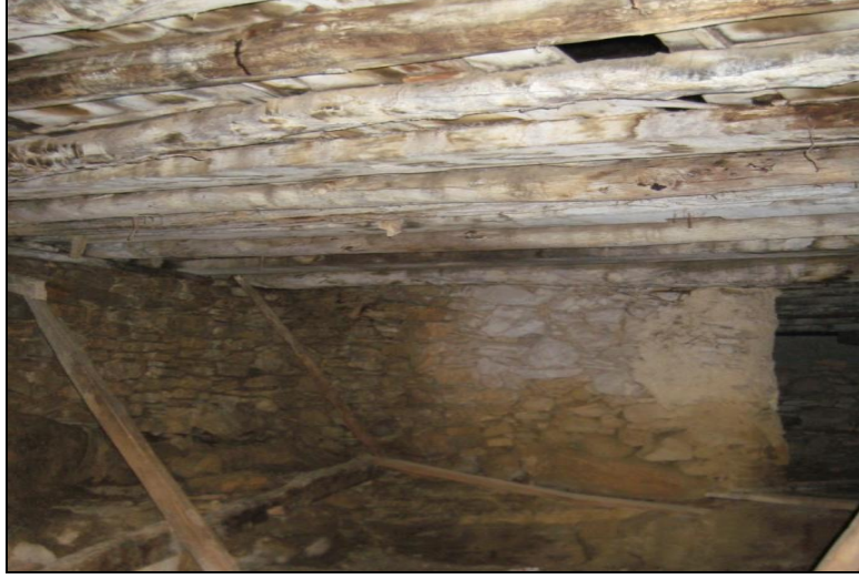
Foto 5: Ahşap döşeme kirişleri (Fotoğraf: K. R. KAVAS)
