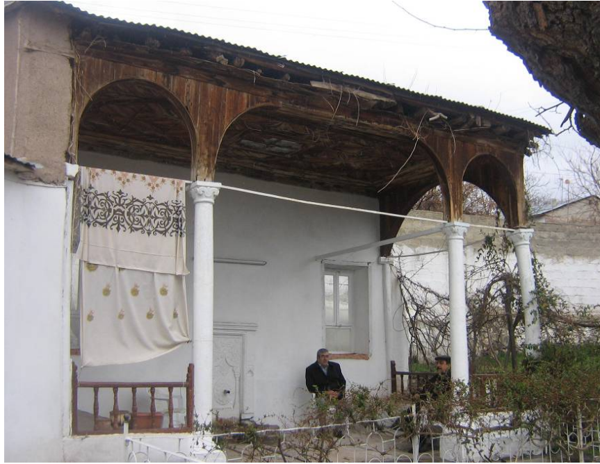
Fotoğraf 2: Havuzbaşı Güneybatı Cepheden Görünüş
