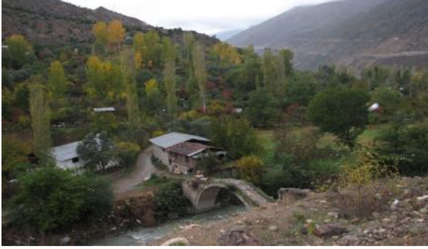
Fotoğraf 8: Avcılar Köyü Köprüsü. Ardanuç, Artvin. Kasım 2006 (Fotoğraf: S. Başkan)
