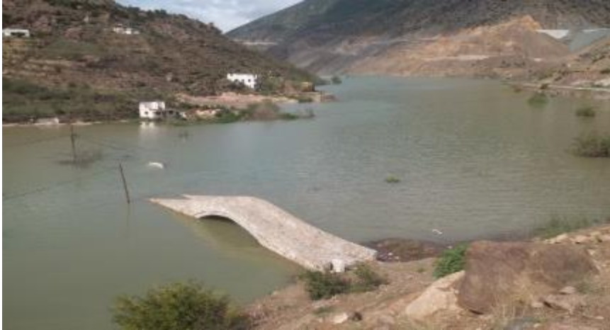
Fotoğraf 9: Avcılar Köyü Köprüsü. Ardanuç, Artvin. Ağustos 2012 (Fotoğraf: M. Kalaycıoğlu, Artvin DSİ 26. Bölge Müdürlüğü)
