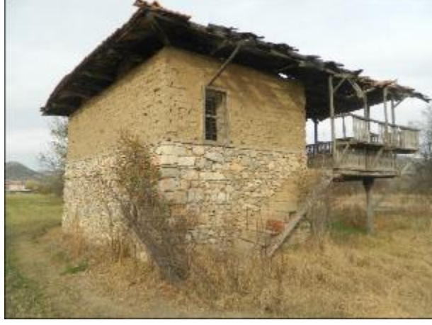
Foto 3: Ev Duvarlarında Malzeme Kullanımı (Fotoğraf: G. KIRAN & E. GÜNEL)
