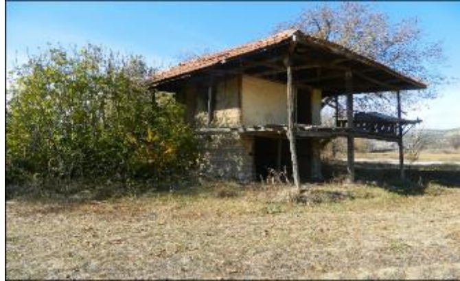
Foto 6: Çatı Taşıyıcı Sistemi (Fotoğraf: G. KIRAN & E. GÜNEL)
