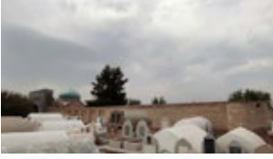
Fotoğraf 4: Güney Cephe Görünümü.
