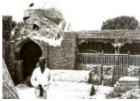
Fotoğraf 24: Yapının Onarım Öncesi Görünümü.
