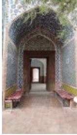
Fotoğraf 6: Taç Kapı Eyvan Nişi.
