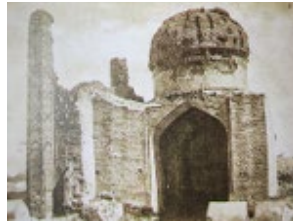
Fotoğraf 32: Batı Cephenin Eski Görünümü.
